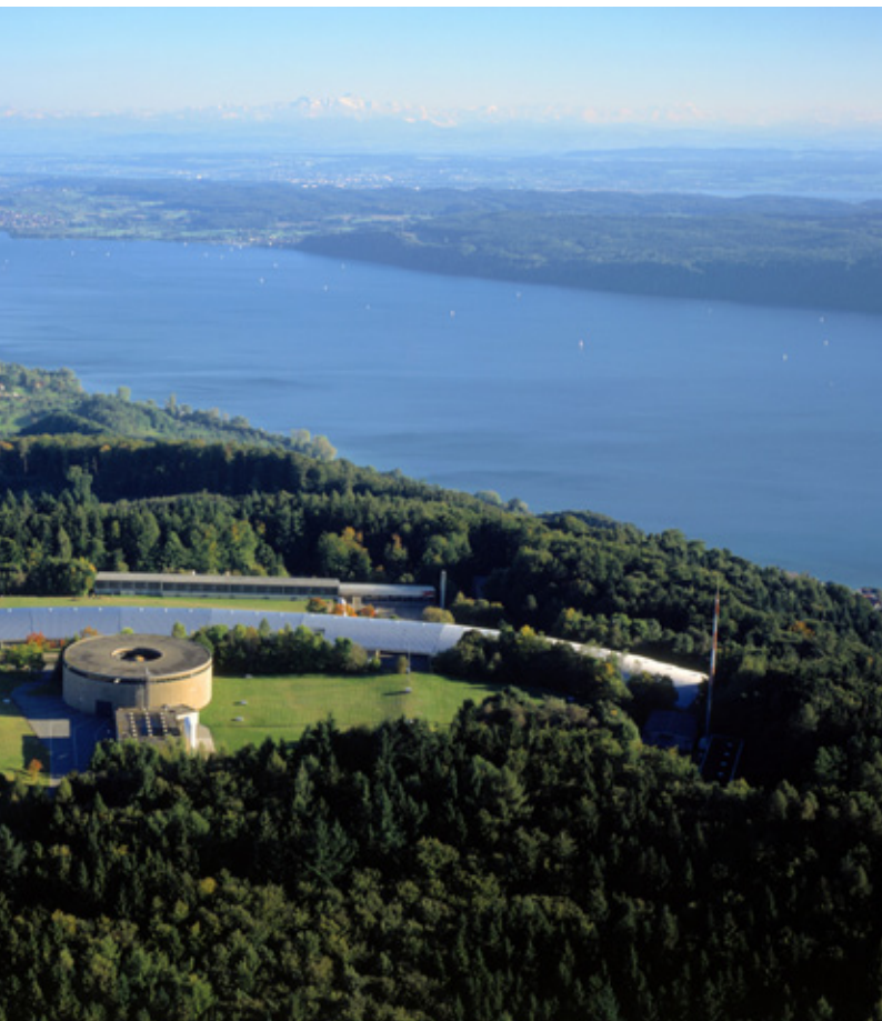
Das Wasserwerk »Sipplinger Berg« der Bodensee Wasserversorgung versorgt 4 Millionen Menschen in Baden-Württemberg mit Trinkwasser.
